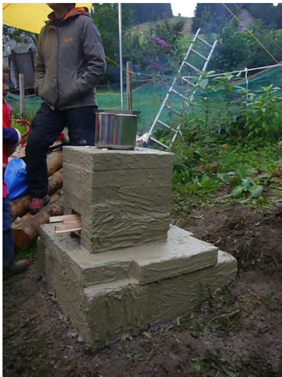
Oben: Bau mit einigen Kindern Bild links: Frisch verputzt im Workshop Lehm/Lehmofen im Juli 2009 Bild rechts: Modifiziertes Grundmodell eines Teilnehmers des Julikurses mit Rohr und Herdplatte zum rausnehmen
