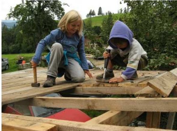
Jonathan (5) und Sophia (8) beim Abbau des Daches des Lehmofen
