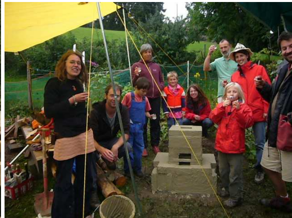
Der Raketenofen ist fertig
