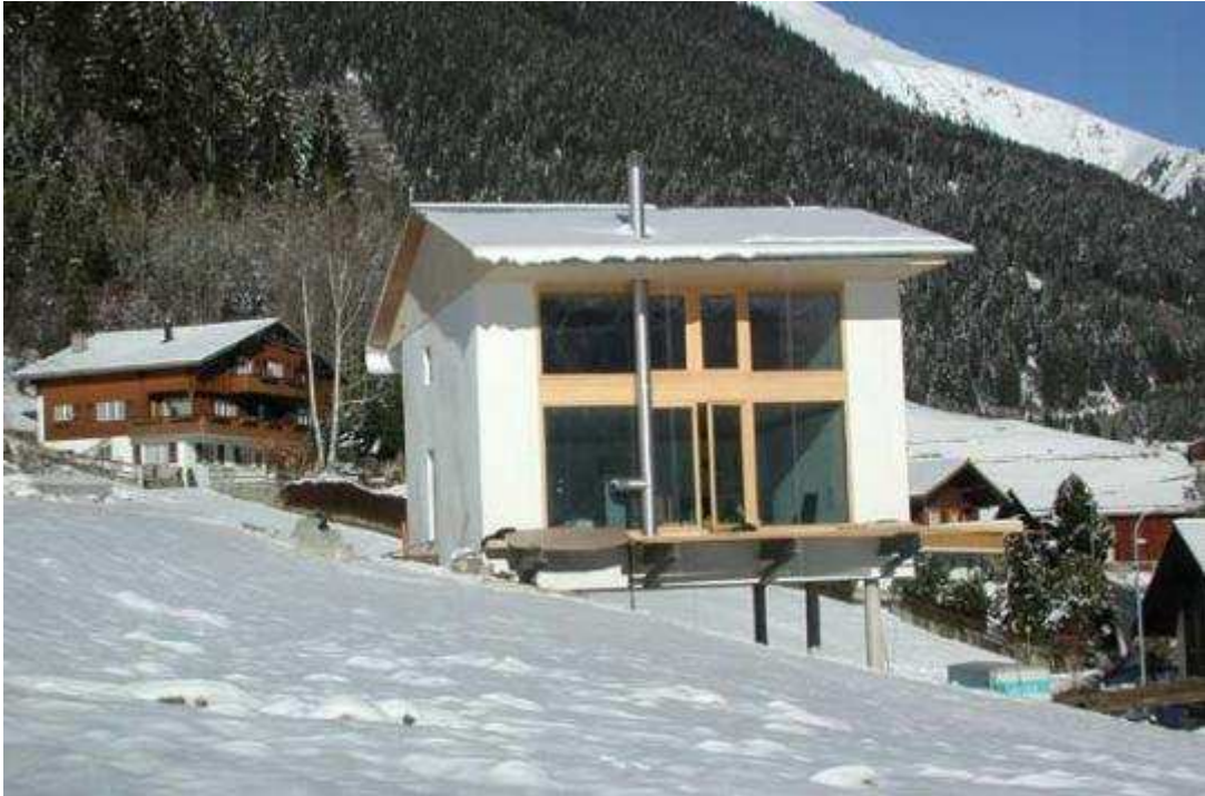
Selbsttragendes Passivhaus !! aus (Jumbo-)Strohballen nach einem Entwurf des Architekten Schmidt in der Schweiz auf 1300m
